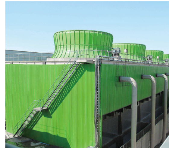
逆流式玻璃钢方形冷却塔
